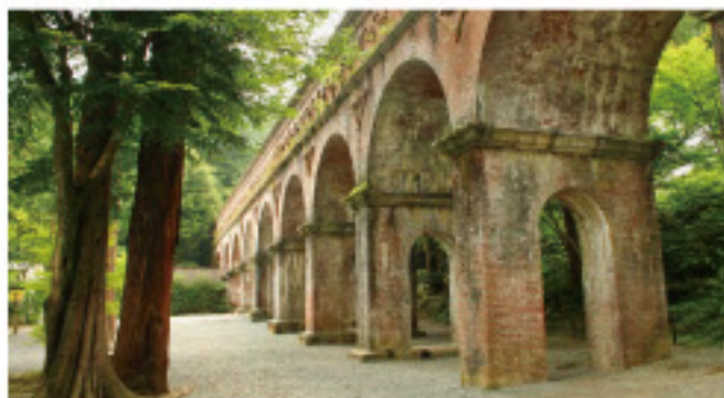
南禅寺水路閣 地下鉄東西線で蹴上駅(2駅)→徒歩10分(約20分)/ホテルから車で約15分
